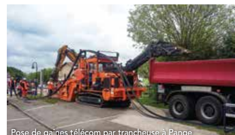
Pose de gaines télécom par trancheuse à Pange
