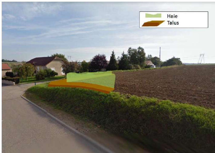
Fig. 31. Implantation d'un talus et d'une haie en aval de la parcelle agricole, BV n°1 Coincy
