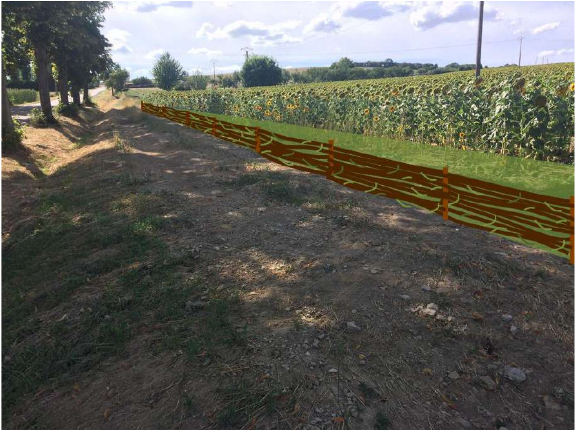
Fig. 88. Mise en place d'une fascine précédée d'une bande enherbée, BV n°2 Servignyles-Raville
