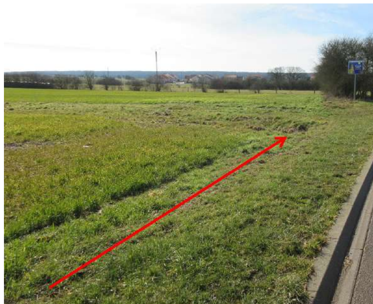
Fig. 83. Fossé à (re)creuser, Sanry-les-Vigy
