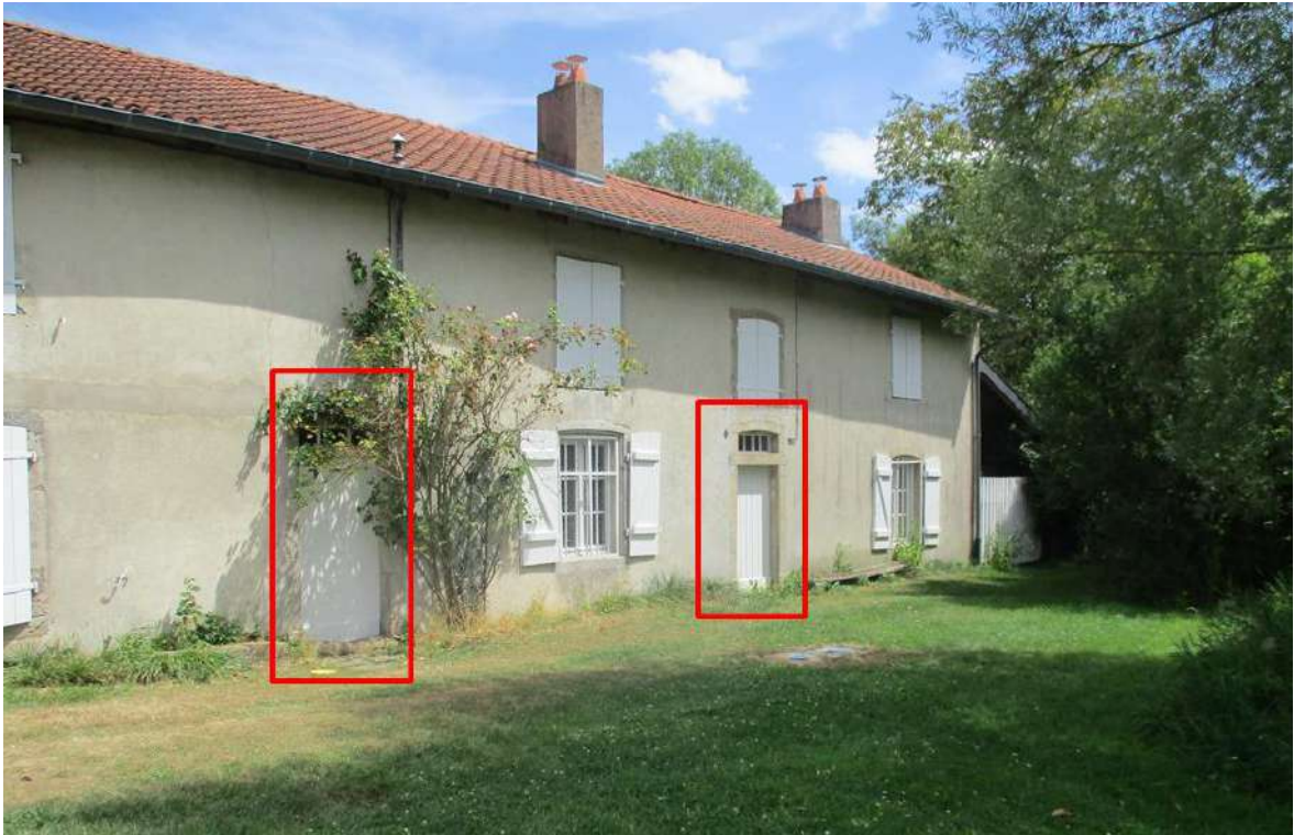
Fig. 97. Protection d'une habitation, Silly-sur-Nied
