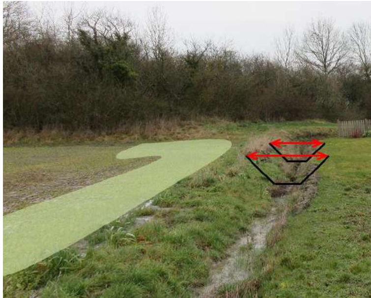
Fig. 19. Fossé à agrandir et bande enherbée à ensemercer, Bazoncourt
