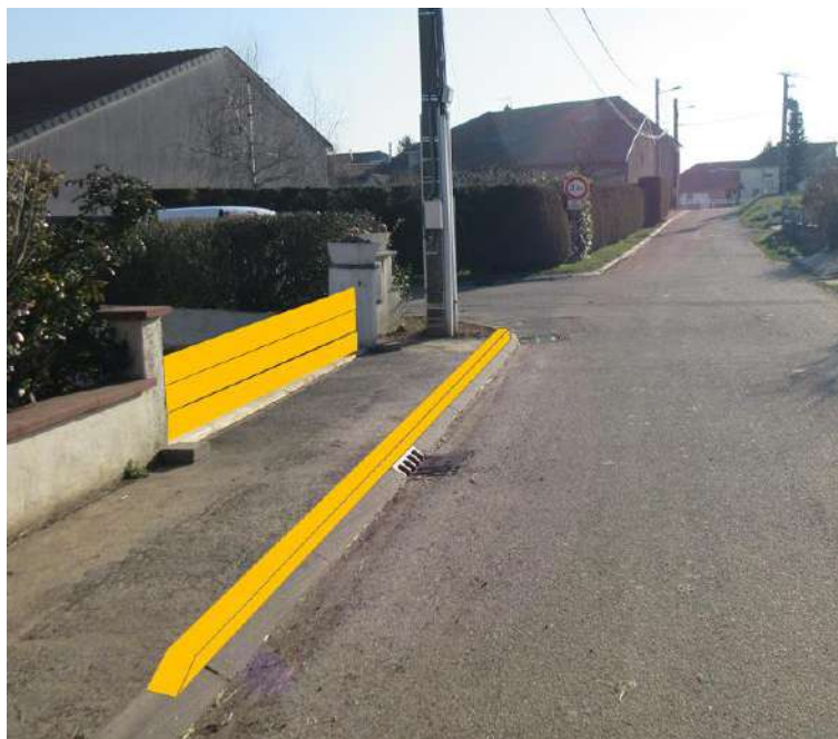
Fig. 44. Trottoir à rehausser et batardeaux à mettre en place, Chailly-sur-Nied
