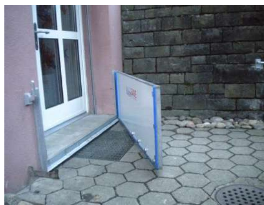
Fig. 16. Illustrations de batardeaux amovibles
