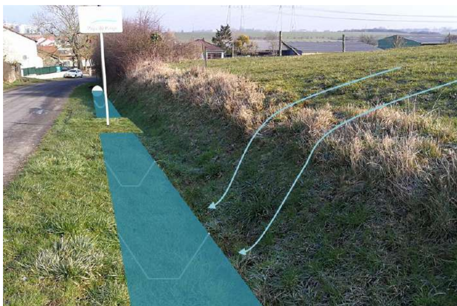
Fig. 32. Reprofilage du fossé, BV n°2 Coincy
