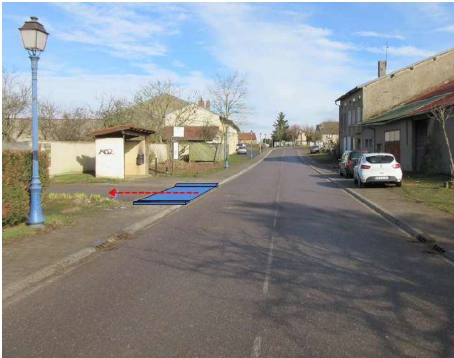
Fig. 80. Abaissement de trottoir, Raville
